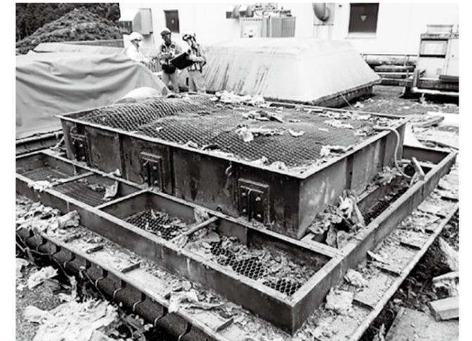
▲爆風により損壊した不燃ごみ処理施設の屋根の上部
